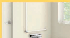
手すりの設置
